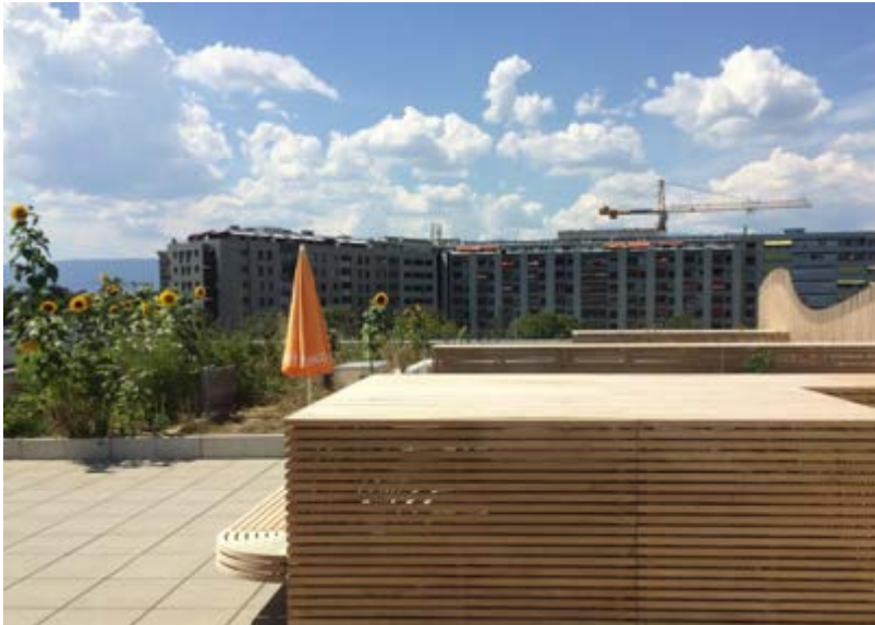
Fig. 93 Référence pour un possible habillage des installations techniques en toiture Stéphane Fuchs architecte, Coopérative Équilibre, Genève
