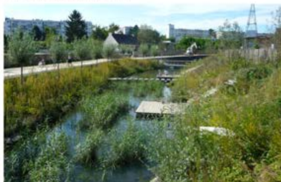
Bassin de rétention
